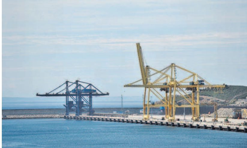
Una empresa turca gestiona la terminal de contenedores del puerto de Ferrol | ÁNGEL MANSO
